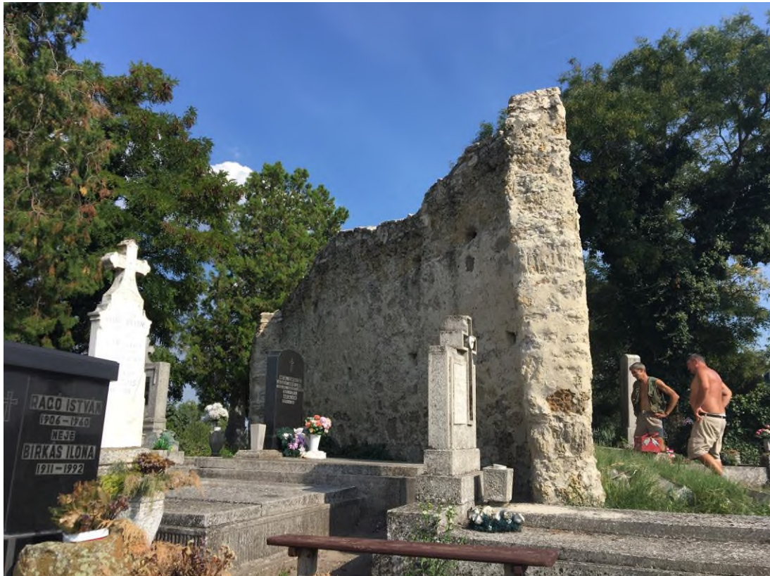
A helyi nyersanyag: a réti mészkő, másnéven darázskő és a mész helyett is használt agyag a középkori templom álló falán
