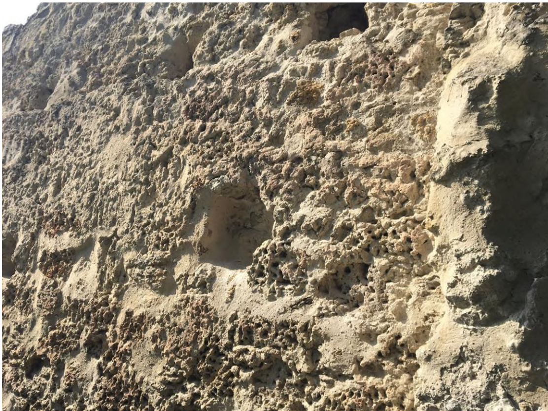
A helyi nyersanyag: a réti mészkő, másnéven darázskő és a mész helyett is használt agyag a középkori templom álló falán
